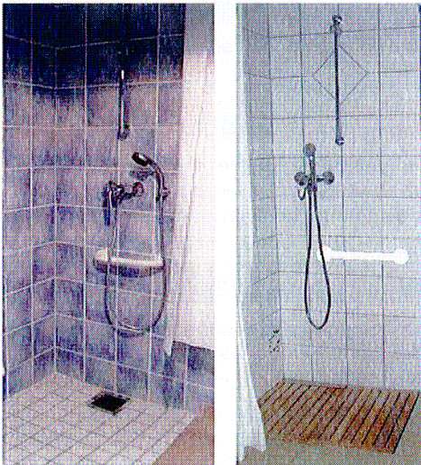
Exemples d'équipements avec un support de douchette en plus de la rampe de douche
