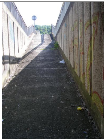
Rampe située à gauche du passage en direction du Monteil
