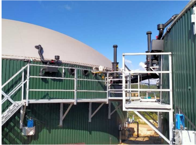
Figure 4 : Dispositif de surpression/dépression
