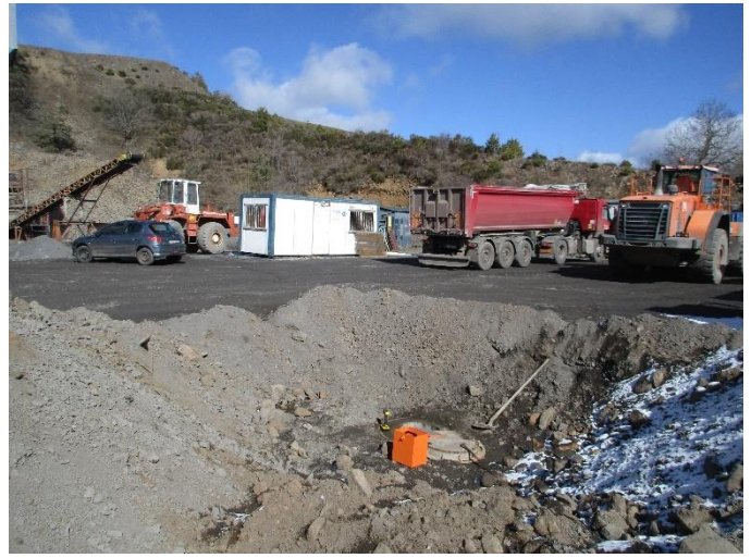
Prises de vues sur le dégagement de la buse protégeant le forage et sonde piézométrique
