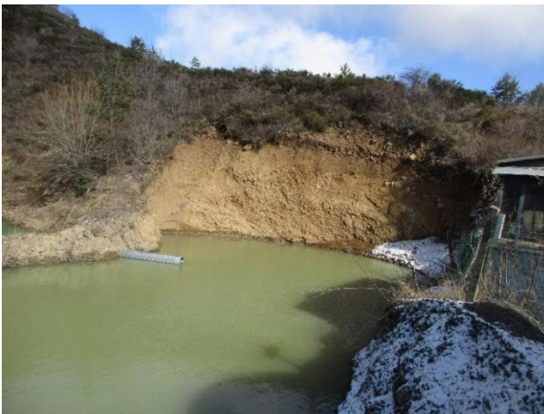
Vue sur un des bassins de rétention
