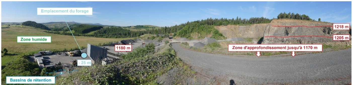
Panorama du carreau de l'aire de traitement à la zone d'extraction
