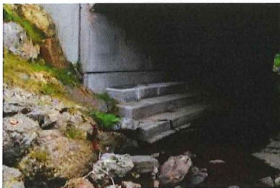
Détail d'un passage à loutre (RN 122, le Lioran). Les blocs rocheux permettent à la loutre de gagner facilement les marches en béton quelle que soit la hauteur de l'eau. Photo C. Lemarchand – Catiche Productions
